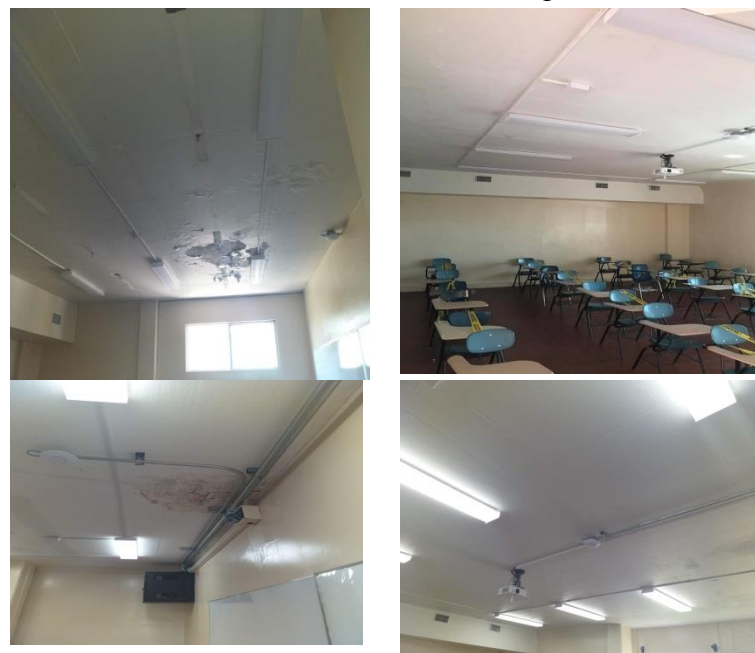
Figura 2. Arreglos en la pintura y techos de los salones en todos los salones del 4to. piso
